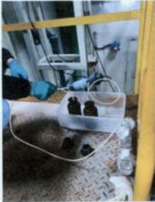
C 区刻蚀废水处理设施进口 04#
