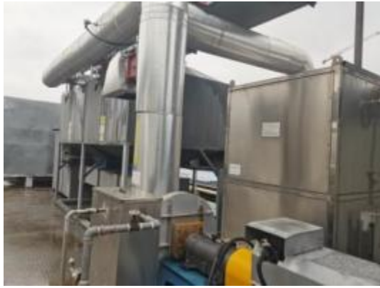
C1 有机废气-沸石吸附+催化燃烧设施
