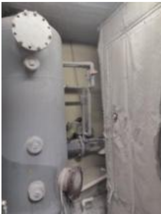
A1 含尘废气-湿式除尘器设施
