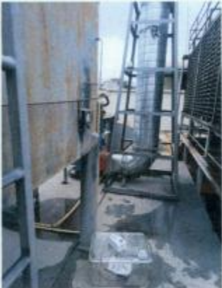
B4 有机废气处理设施出口 17#
