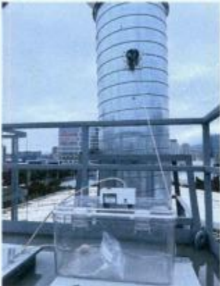
B1 有机废气处理设施出口 15#
